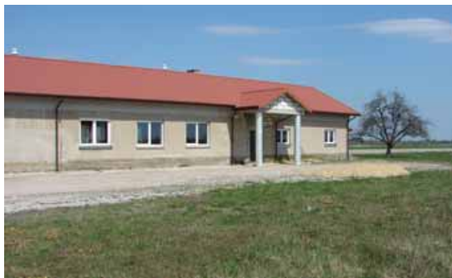
Na zdjęciu: Dom Ludowy w Glinie - w 2008 r. dokonano remontu dachu
