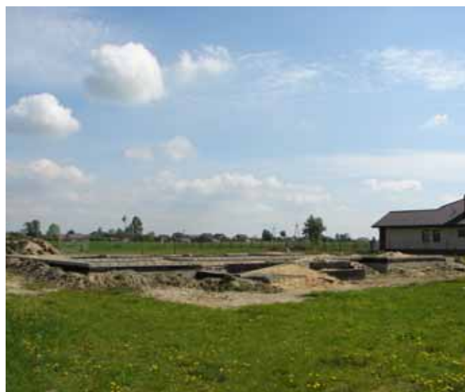
Na zdjęciu: Wykonane w 2008 r. fundamenty pod budynek Domu Ludowego w Siomkach
