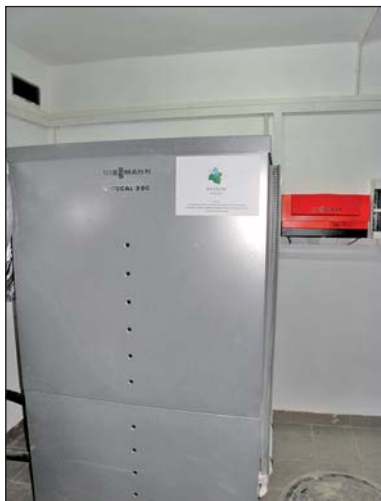
Na zdjęciu (obok): pompa ciepła zainstalowana w przedszkolu, służąca do podgrzewu ciepłej wody użytkowej oraz wspomagająca układ centralnego ogrzewania
