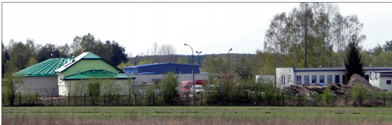
Na zdjęciu: panorama nowej oczyszczalni ścieków
