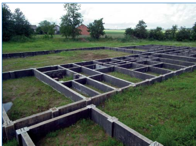
Fundamenty pod rozbudowę szkoły w Bujnach
